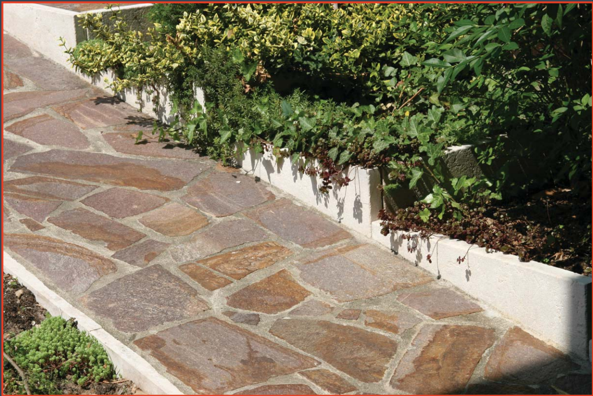
Natúr porfír lejáró és homokfúvott mészkő támfal Natural porphyre driveway and sandblasted limestone abutment
