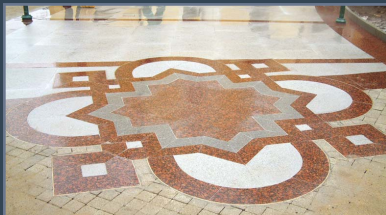
Faragott mészkő kerítés és gránit intarzia • (Debrecen, Csokonai Színház) Carved limestone fence and granite inlay • (Debrecen, Csokonai Theatre)
