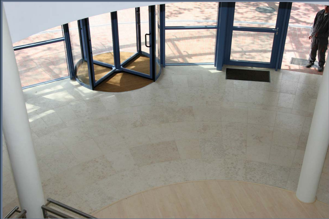
A bejárat padlójához íves oldalú burkolólapokat gyártottunk For floor of the entrance we made tiles with curved sides
