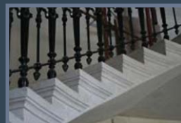
Tömör mészkőelemekből faragott önhordó lépcső • (Várkert Bazár - Budapest) Self-holding stairway with carved solid limestone elements • (The Castle Garden Bazaar - Budapest)
