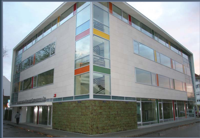
Rozsdamentes tartószerkezettel rögzített Selina Gold mészkő homlokzat
