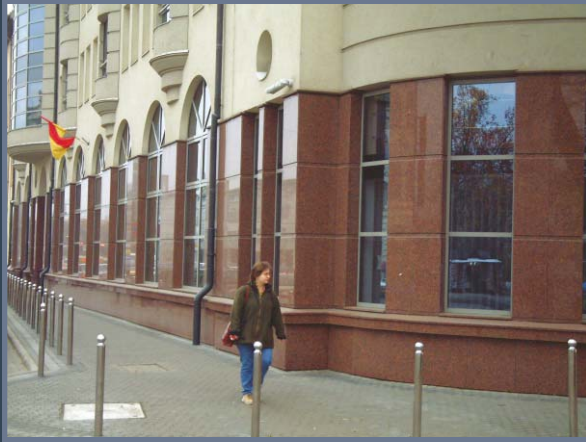
Rozsdamentes tartószerkezettel rögzített gránit homlokzat Granite facade mounted with galvanized iron fixing elements
