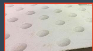
Stokkolt lépcső és taktilis sávok mészkőből Limestone stair with bush- hammered surface and tactile bars
