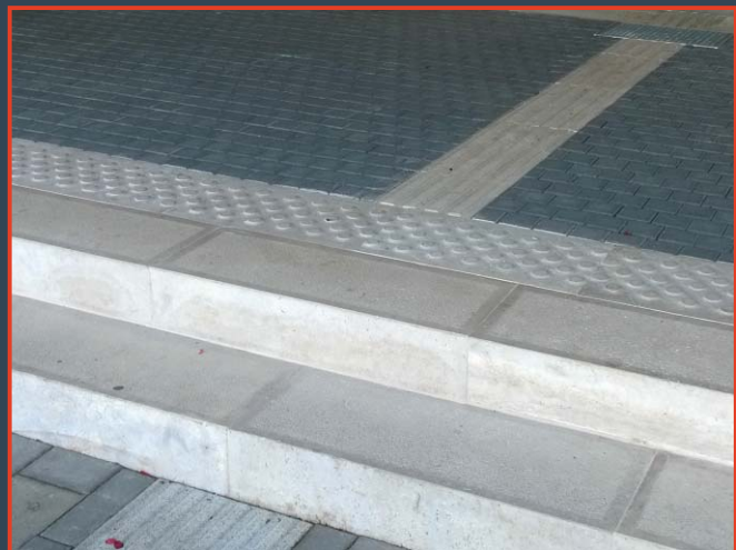
Stokkolt lépcső és taktilis sávok mészkőből Limestone stair with bush- hammered surface and tactile bars
