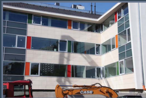
HBKIK irodaház • (Debrecen) Building of HBKIK • (Debrecen)
