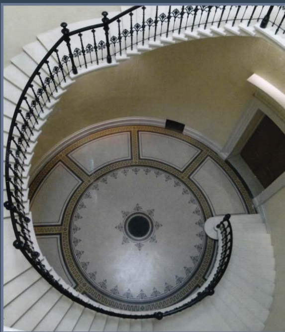
Tömör mészkőelemekből faragott önhordó lépcső • (Várkert Bazár - Budapest) Self-holding stairway with carved solid limestone elements • (The Castle Garden Bazaar - Budapest)
