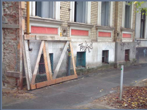
A homlokzat felújítás előtt The facade before renewal
