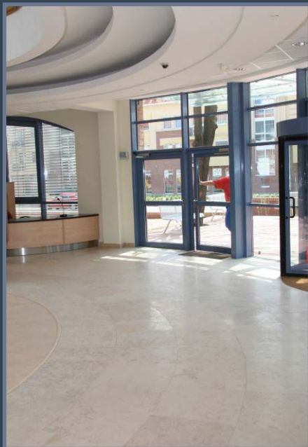
A bejárat padlójához íves oldalú burkolólapokat gyártottunk For floor of the entrance we made tiles with curved sides
