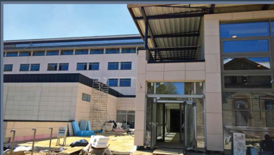
Fehér mészkőburkolat átszellőztetett homlokzaton • Testnevelési Egyetem • (Budapest) White limestone on ventilated facades • University of Physical Education • (Budapest)
