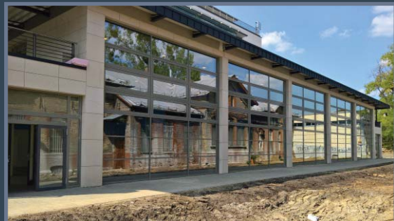
Fehér mészkőburkolat átszellőztetett homlokzaton • Testnevelési Egyetem • (Budapest) White limestone on ventilated facades • University of Physical Education • (Budapest)
